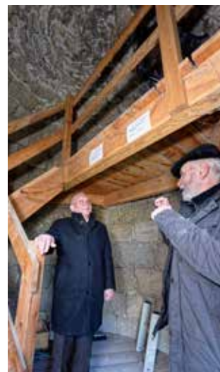
Vereinsvorsitzender Volker Pethe erklärt Oberbürgermeister Frank Ruch die Sanierungsarbeiten im Lethurm (Foto: Jürgen Meusel)
