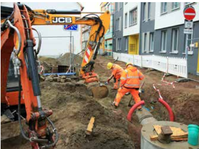
Bauarbeiten in Höhe Essiggasse
