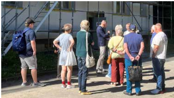
Großes Interesse am Schautag: Wowi-Mitarbeiter Robert Jung begrüßt die Gäste des Schautages und gibt einen Überblick über das Sanierungsprojekt in der Gartenstraße 6 - 8
