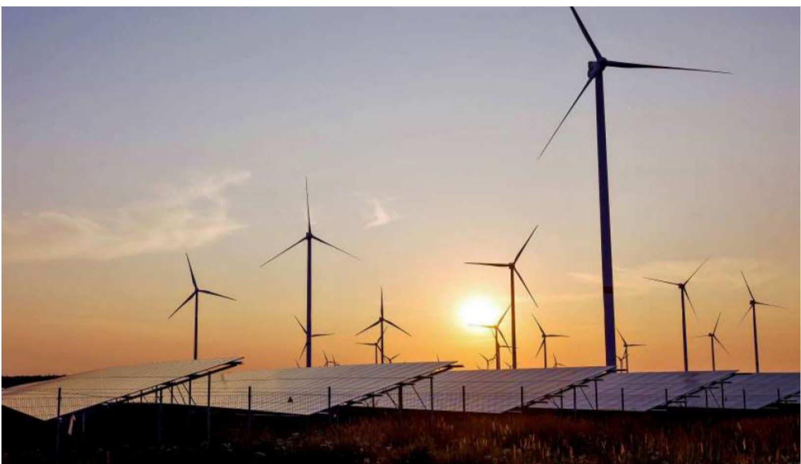
Mit dem „Zukunftsprojekt Morgenrot“ planen private Investoren auch die Entwicklung eines Energieparks.
