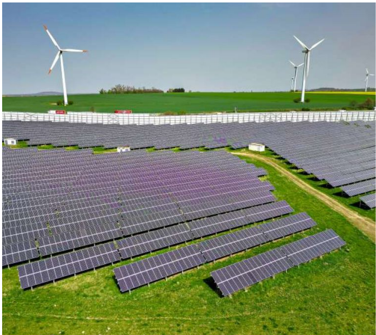
Mit dem Zukunftsprojekt Morgenrot sollen auch Photovoltaikanlagen und Windräder entstehen.
