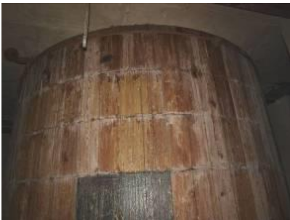
Ehemaliger Behälter der Farbchemie
