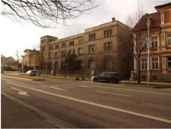
Hohe Frontseite zum Harzweg - bleibt als Bürotrakt erhalten
