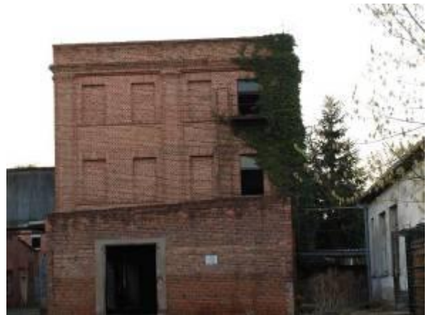
Östlicher Gebäudetrakt im Winterhalbjahr zum Abbruch bestimmt
