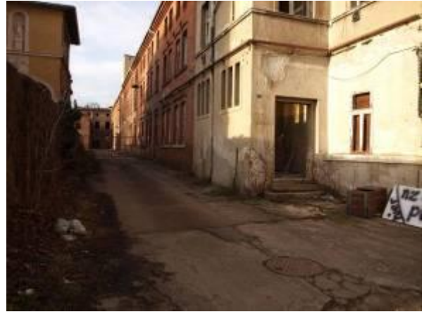
Westlicher Gebäudetrakt zum Abbruch bestimmt
