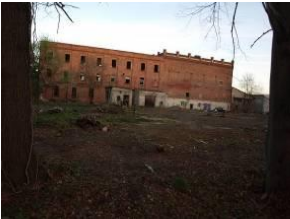
Gebäudefront und Hofseite nach Norden mit großflächigen Versiegelungen
