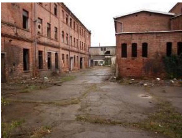
Versiegelte Flächen und Gebäudebestand mitten im Plangebiet zum Abbruch bestimmt
