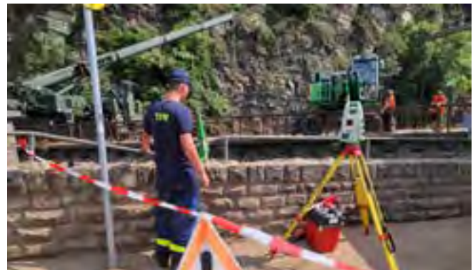
Statiküberwachung einer Brücke
