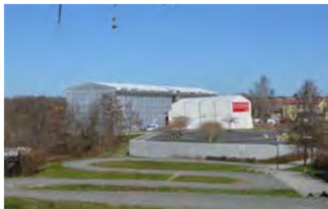
Unter einer Hülle, geschützt vor Wind und Wetter, ist der Baukörper des Wohnprojektes Jacobsgarten, gewachsen. (Foto: Andreas Damm / ESN)
