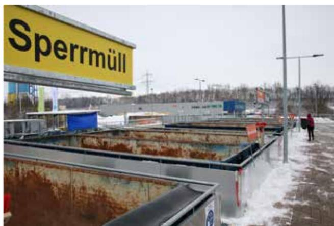
Durch die erhöhte Fläche können die Container bequem von oben befüllt werden. Lediglich das aus Sicherheitsgründen erforderliche Geländer muss überwunden werden. Das Treppen steigen mit dem Abfall wie auf älteren Höfen entfällt.
