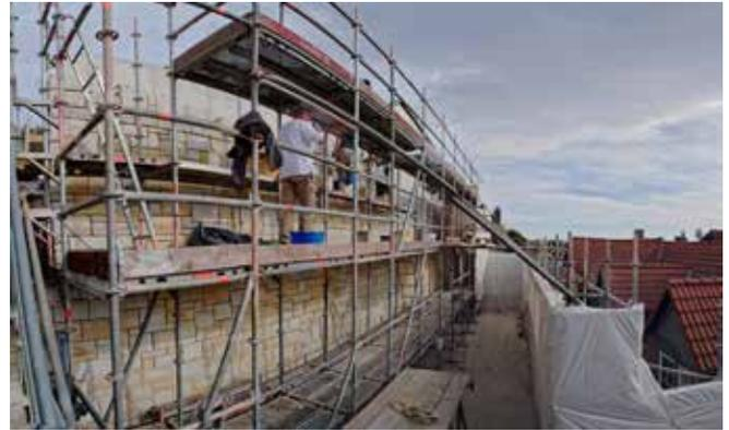
Die neue Stahlbetonwand wird mit Sandstein verblendet
